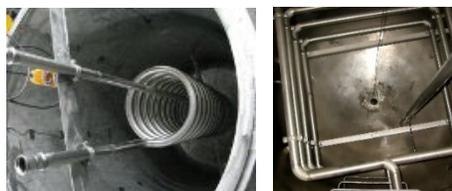
*Fuso de aquecimento dentro de um tanque: Sem problema para os sensores TDR com sonda coaxial. As bobinas de aquecimento também não são fonte de interferência com sondas coaxiais.*
